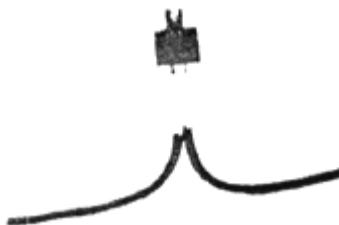
Рис. 11. Подготовленные к огарке жилы кабеля с термитным патроном марки АС
